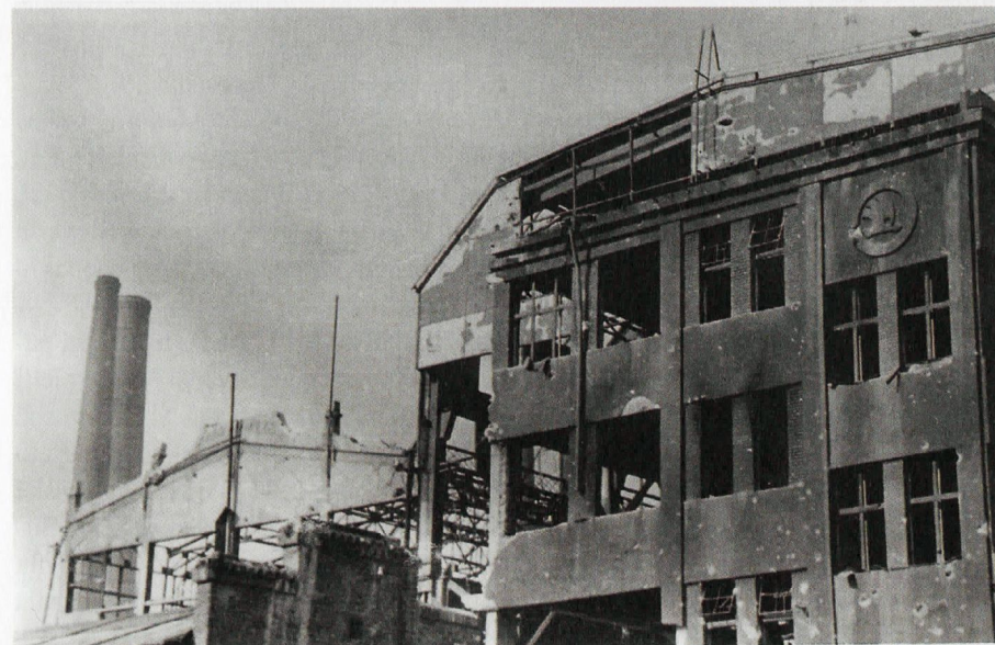
Poř�kozený štít Strojírny I.
