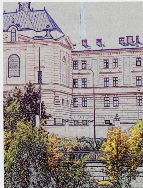
Zadní trakt bývalé věznice.
