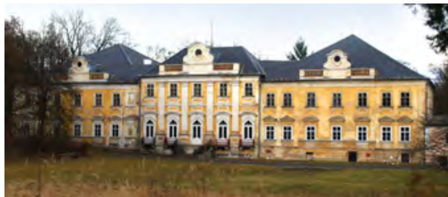
Současný stav dnes nepřístupného hlubošského zámku. Pohled od jihovýchodu.
