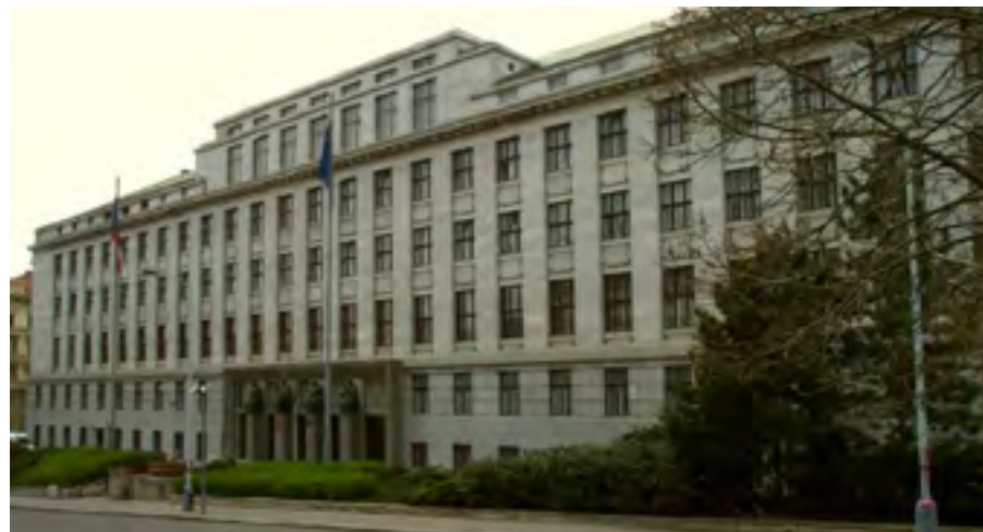
Neoklasicistní budova ministerstva zemědělství na nábr. Ludvíka Svobody. Kvůli zpevnění terénu stojí na 1 740 pilotech. Při stavbě se použila tehdy nejmodernější technika (čtyřicetimetrové jeřáby) a technologie (železobeton a poprvé v Praze litý beton).
