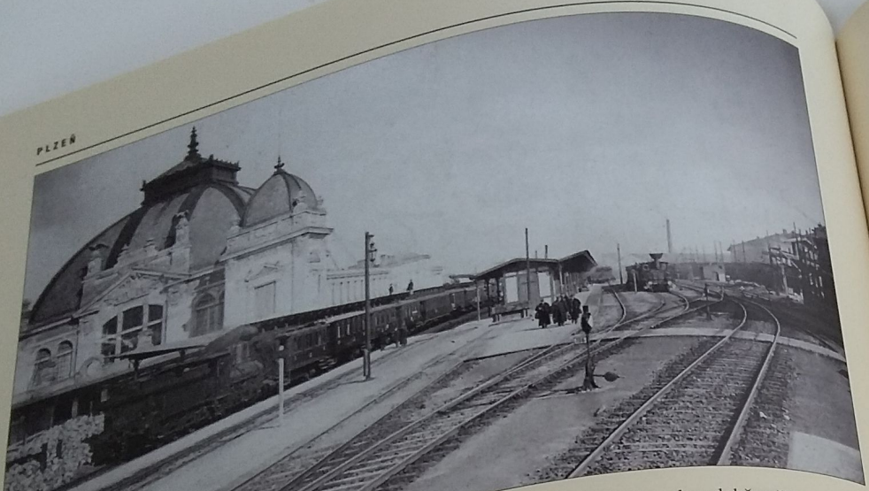
Rok 1907 Posunující lokomotiva řady 40 kdysi patřivala do parku České západní dráhy, ale v době pořízení snímku ji vlastnily Rakouské státní dráhy. Nová nádražní budova nebyla v době pořízení snímku ještě zcela dokončena.
