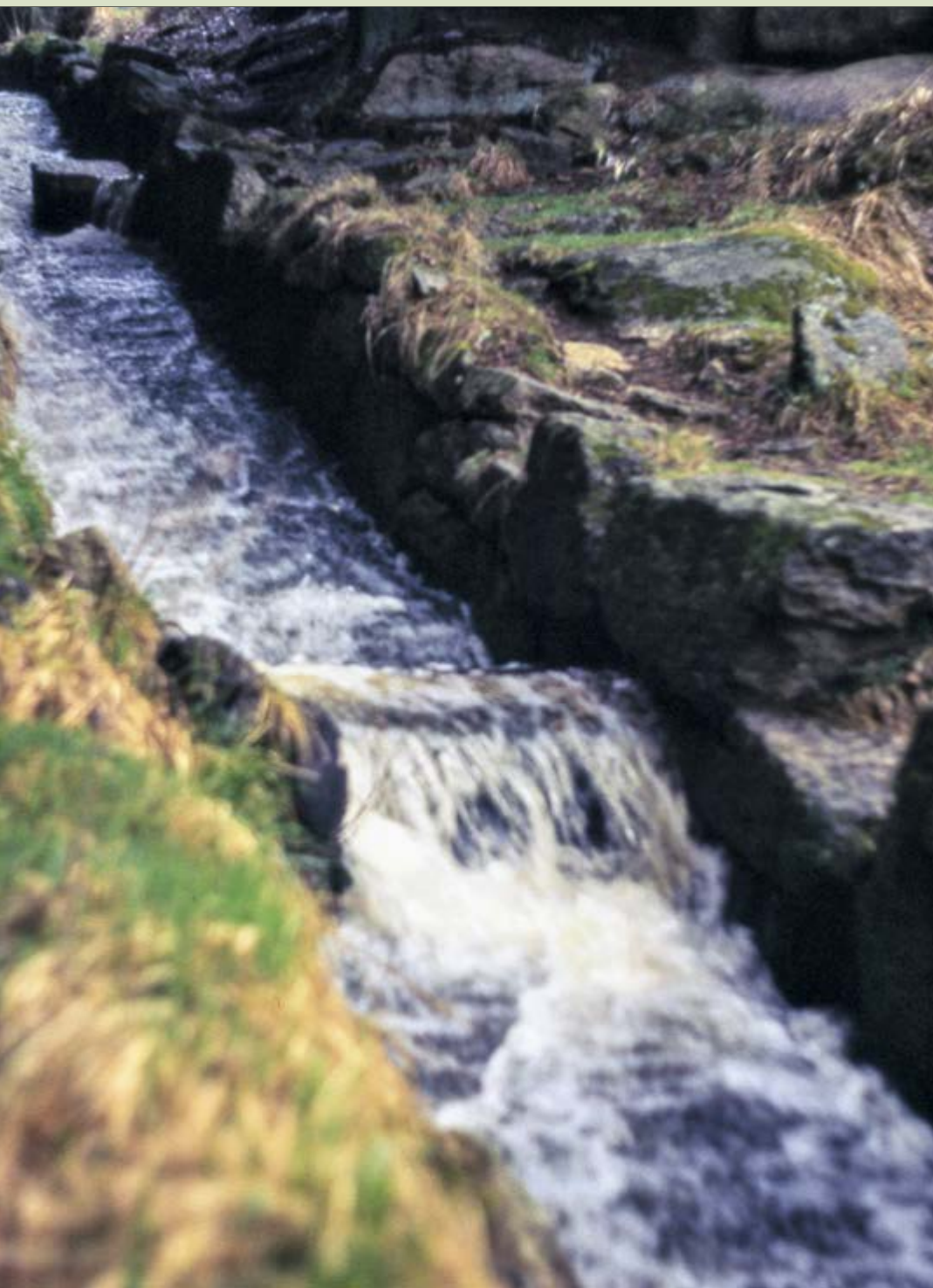
únor 1989 / Do plavebního kanálu ústily přítoky (tzv. smyky), na jejichž tocích byly umělé nádržky, a umožňovaly tak dopravu dřeva z výše položených lokalit. U stavidla na Jelením jezírku ústí do kanálu kanalizovaný Jelení potok.
