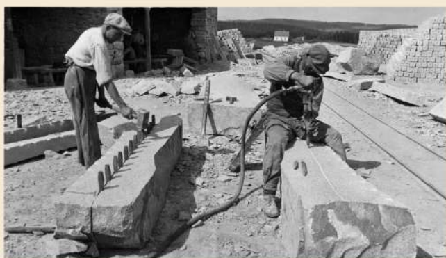
Dělení žulového kvádrů pro svatohorské schody v nečinském lomu firmy J. Rada a syn
