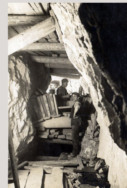
Zdivo k podchyčení základky
