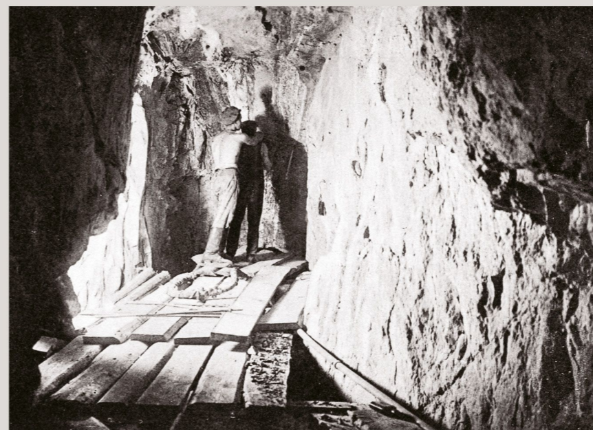
Strojní dobývání na výstupky
