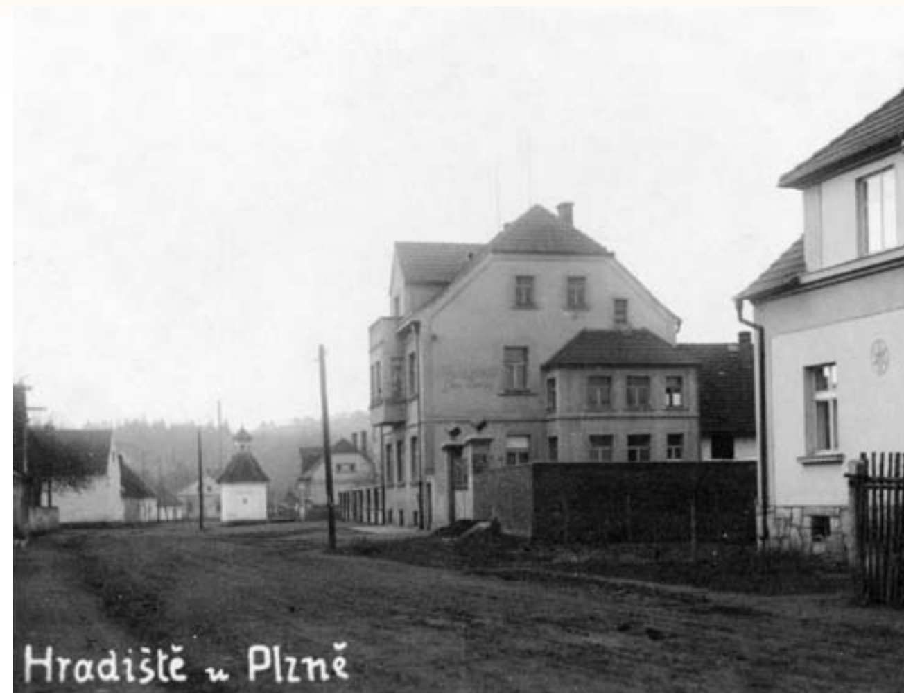
Pohled ulicí Na Rychtě směrem k domu, kde bývalo truhlářství Jana Černého spoluzakladatele Sokola v Hradišti, a k návěsní kapli (20. léta 20. století)
