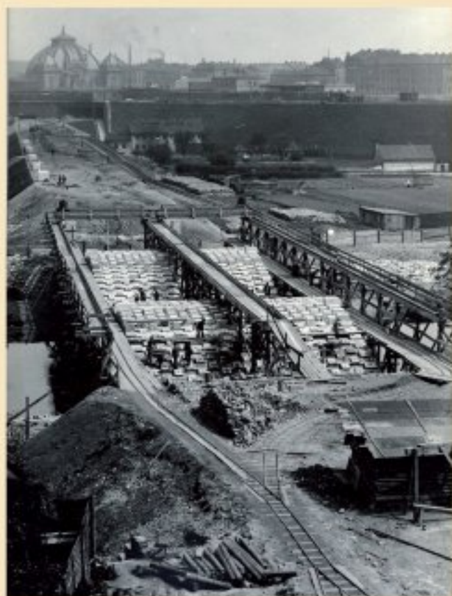
Stavba mostu Císaře Františka Josefa I, firmou Müller & Kapsa (1912)
