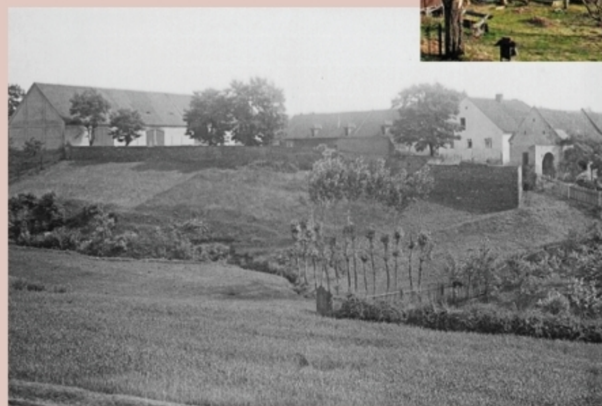
Panský dvůr v pohledu od severu přes Hrádecký potok kolem roku 1915 a v roce 2007.
