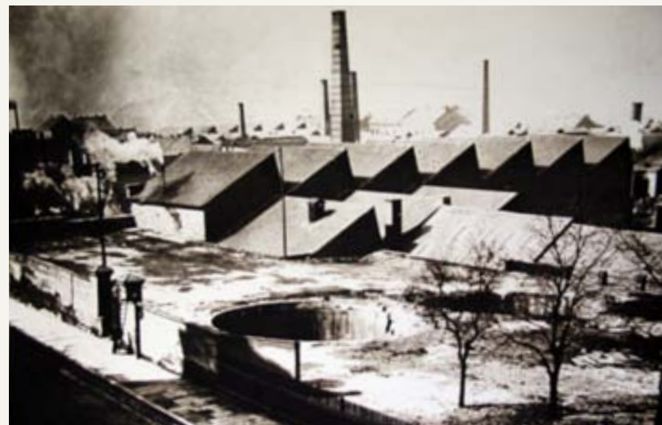
Stará plynárna, pohled z dnešní Husovy ulice. Sousedila s Valdštejnskou strojárnou.
