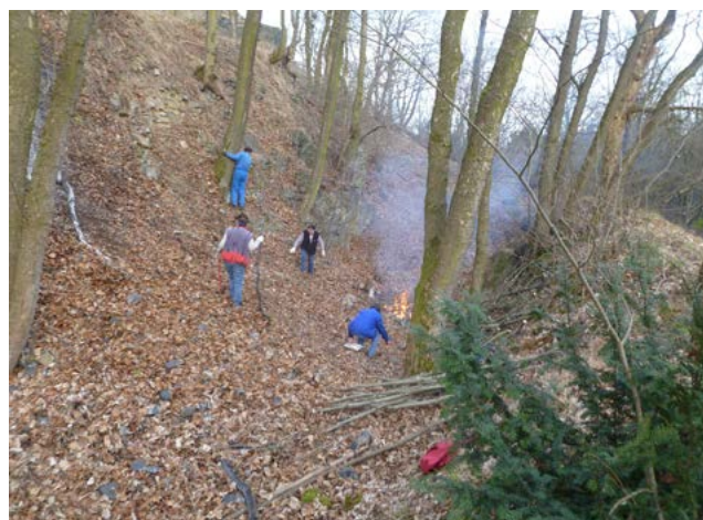
Práce při čištění jižního hradního příkopu, 2014
